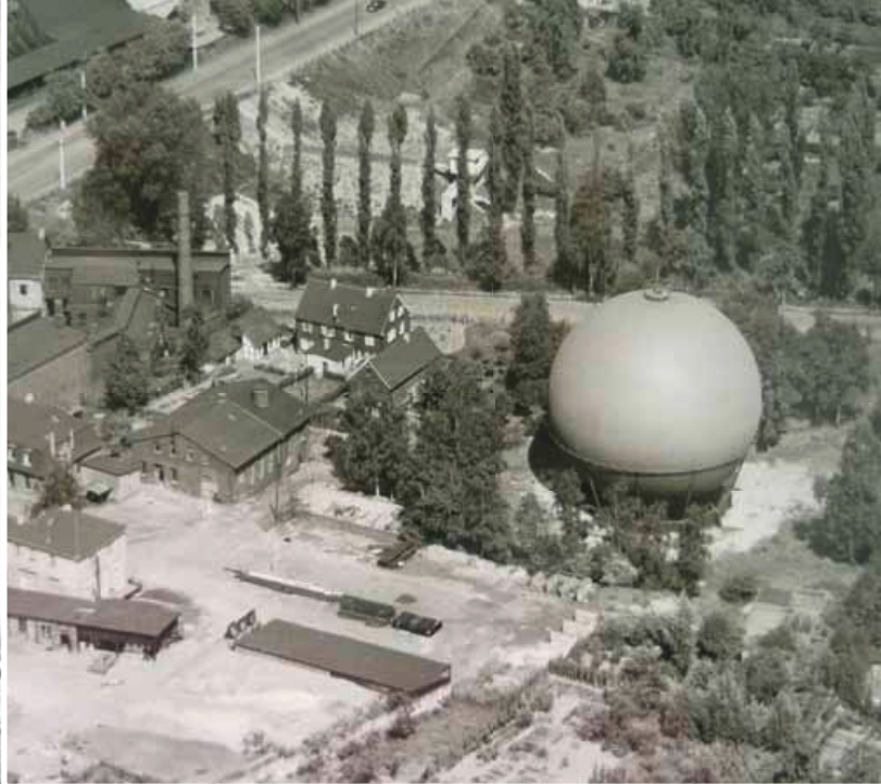
1956/57 wurde der Kugelgaspeicher an der Tunnelstraße in Ohligs gebaut. Er fasste bis zu 77 775 Norm-Kubikmeter Gas. Damit konnte man Solingen an einem warmen Sommertag für einen dreiviertel Tag versorgen.
